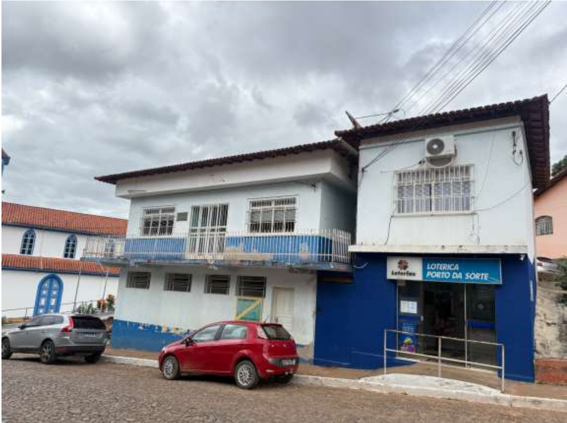
Vista frontal ampliada da edificação, com destaque para fachada, cobertura e entorno urbano.
