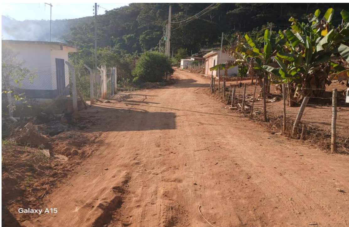
Condição atual da pista de rolamento sem pavimentação.
