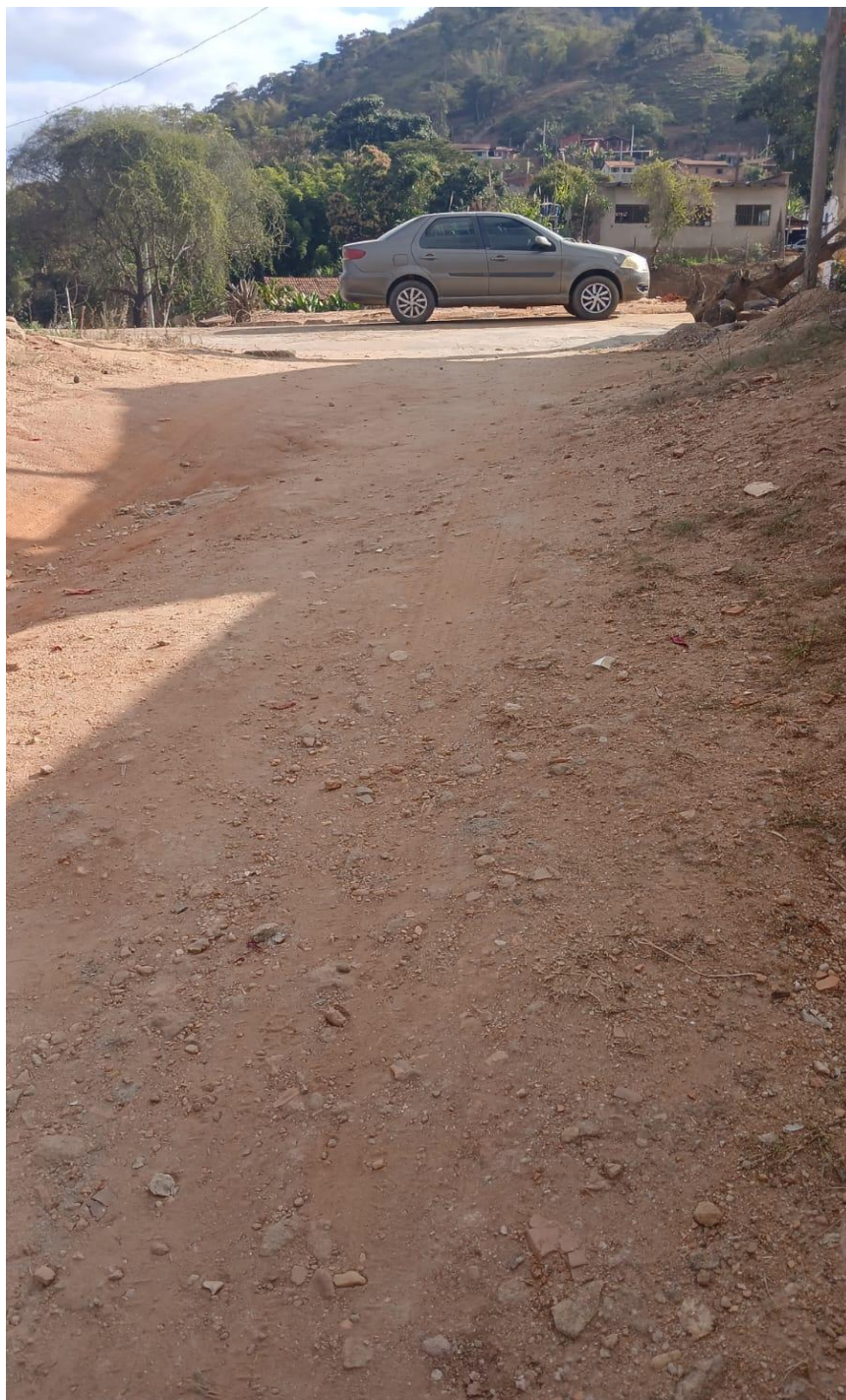
Foto 03 – Vista do trecho em direção à ligação com a via existente, registrando a superfície atual em solo natural.
